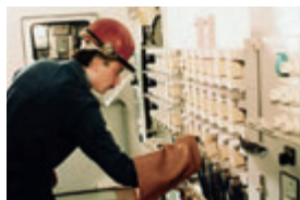
Bild 3.2.4 – Betätigung von NH-Sicherungseinsätzen unter Last
