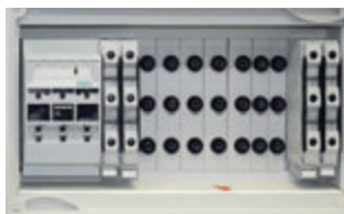
Bild 3.3.4 – Reiterelemente auf Sammelschienensystem SR60
