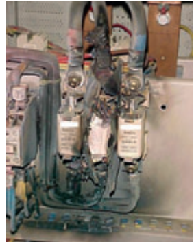
Bild 5.8.1 – Missglückte Abschaltung einer Stromresonanz
